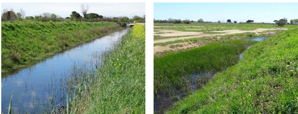
Cours d'eau sur le secteur est
