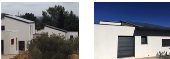
Solaire PV sur maisons individuelles aux Matelles – photo LF/PLUS DE VERT
