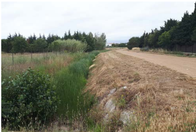
Fossé de drainage
