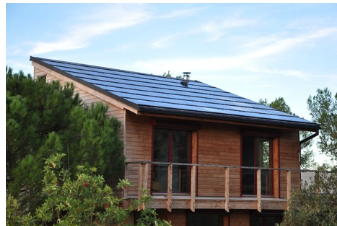
Maisons à énergie positive – toiture monopente en tuiles photovoltaïques - Les Matelles (34) Photo L. FARAVEL/PLUS DE VERT
