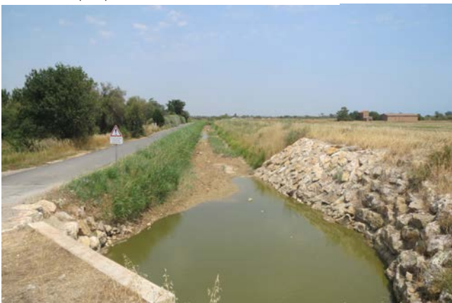
Canal de drainage
