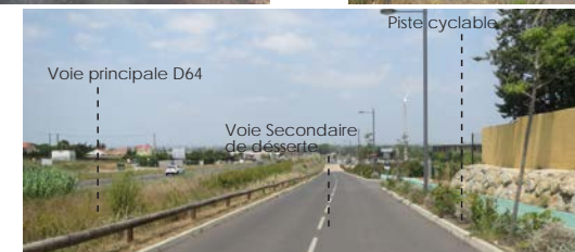
Vieilles routes séparées par de plus ou moins larges bandes végétales intégrant. Noues, éclairage et éléments mobiliers. La traversée de la D64 n'est possible qu'aux ronds points Nord et Sud.
