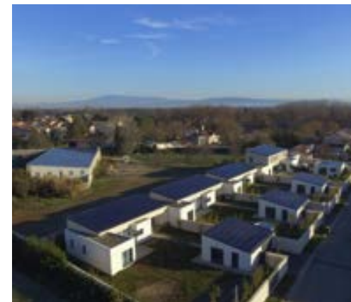
Maisons en bande à énergie positive – toitures monopentes ou plates - (Bouches-du-Rhône)
