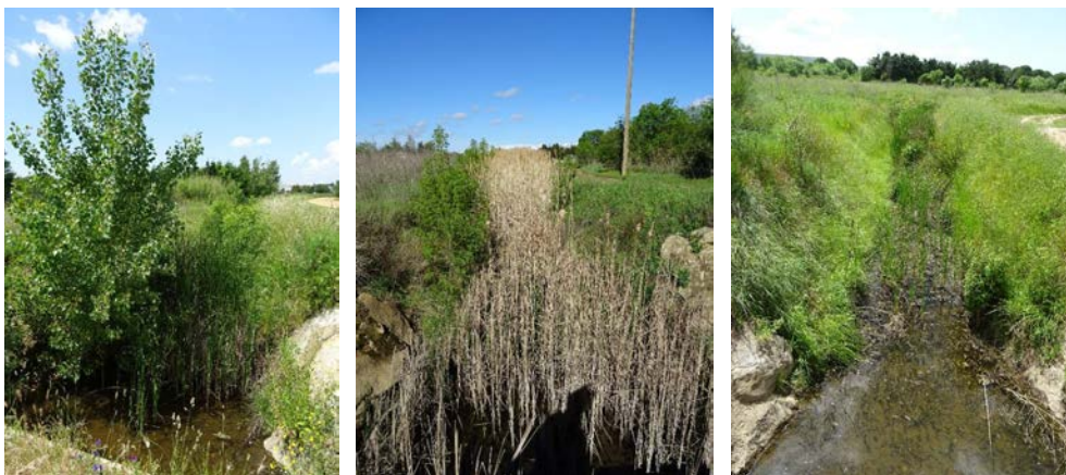
Cours d'eau sur le secteur ouest
