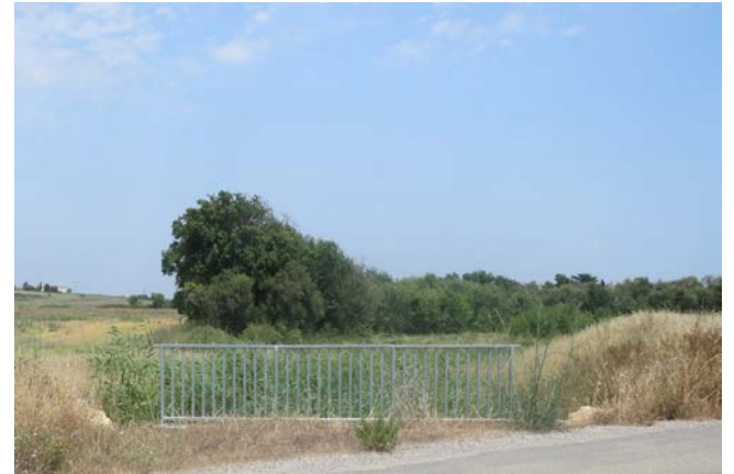
Canal de drainage avec peuplement de canne de provence et ripisylve
