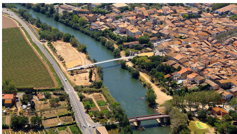
Photo de l'entrée de ville nord de Sérignan, ceinturée par l'Orb et ses ouvrages de franchissements
